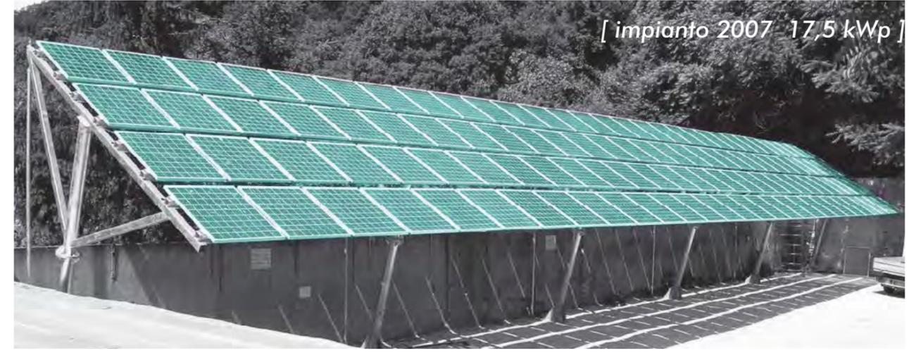
Il secondo impianto fotovoltaico di 17,5 kWp, realizzato nel 2007, è una pensilina per auto nel parcheggio con 100 pannelli fotovoltaici installati e in grado di produrre l'energia necessaria a coprire il consumo degli uffici, dello shop e della biglietteria del museo.
